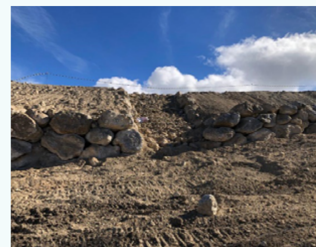
Disipador de energía
