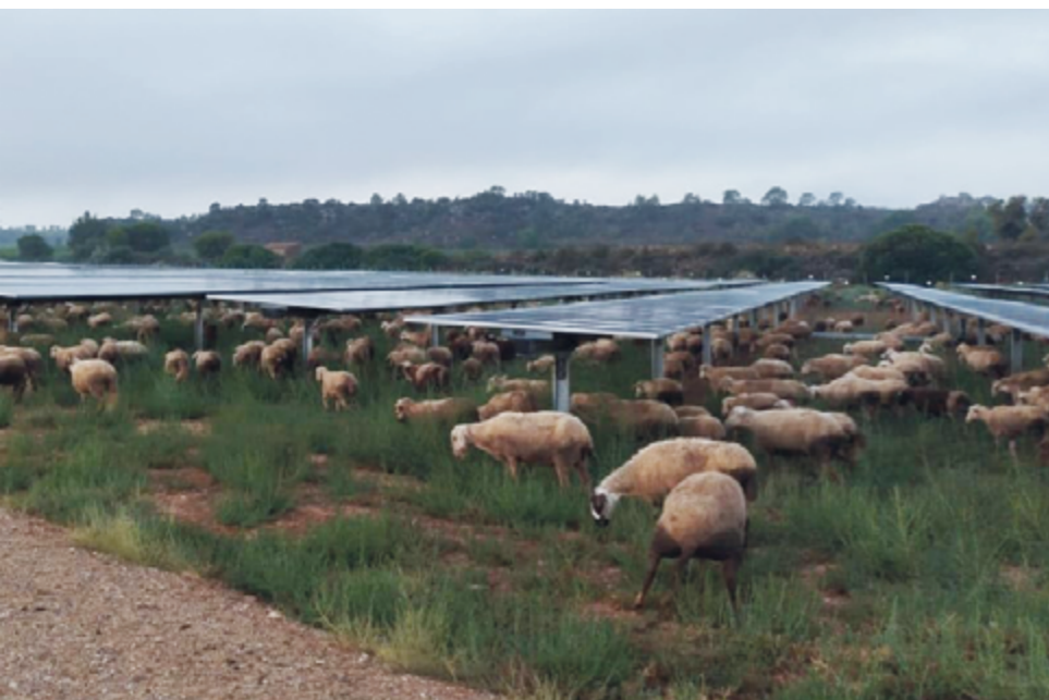
Planta fotovoltaica "Ignis Generación Solar" Escatrón (Zaragoza)
